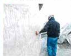
鉄筋探査状況電磁波レーダー
