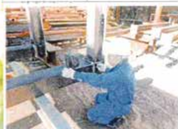
鉄骨溶接部検査状況
