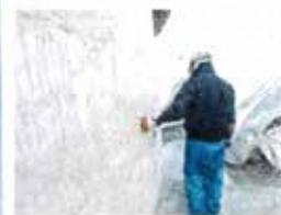
鉄筋探査状況電磁波レーダー
