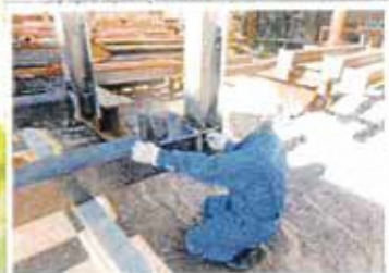
鉄骨溶接部検査状況
